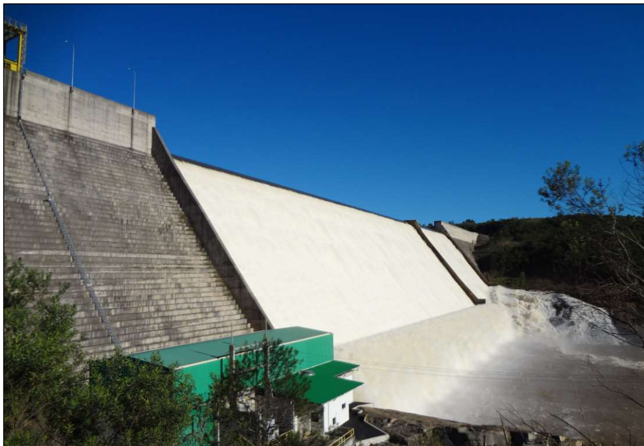
FIGURA 2.2 UHE SANTA CLARA – VISTA DE JUSANTE
