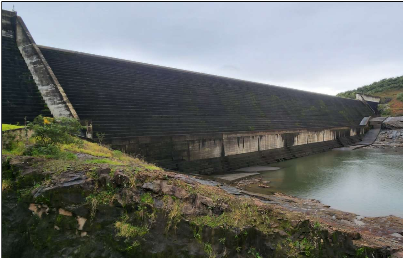
FIGURA 2.5 UHE FUNDÃO – VISTA DE JUSANTE
