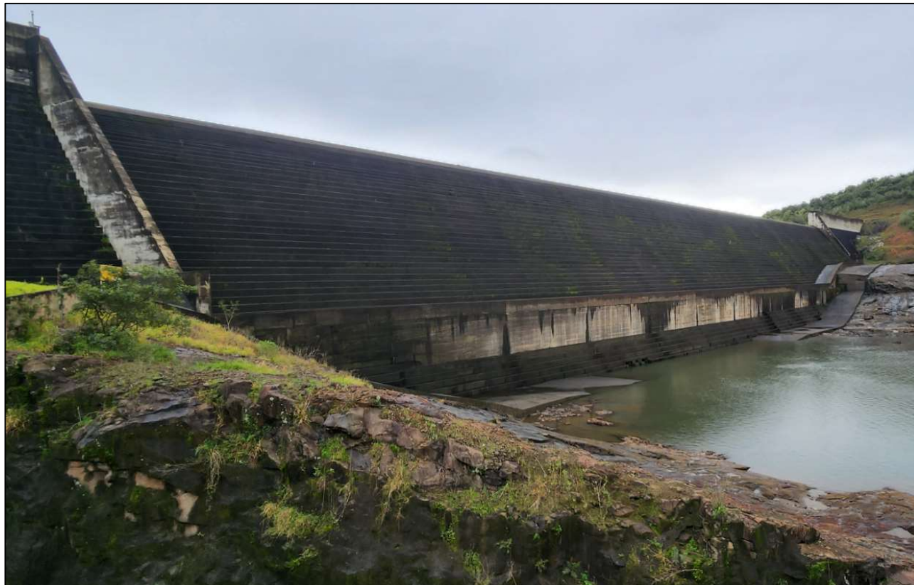
FIGURA 2.5 UHE FUNDÃO – VISTA DE JUSANTE
